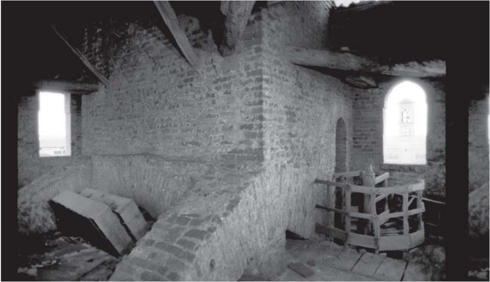
Sopra, archi per il sostegno fuori asse della Torre campanaria. Sotto, un particolare.
