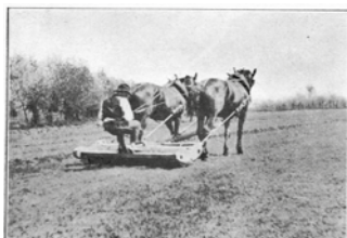
Rullatura per lisciare la superficie.
