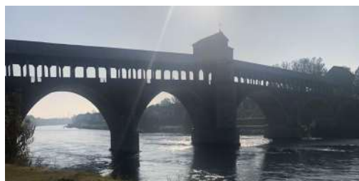
Lo storico Ponte Coperto (Vecchio) di Pavia
